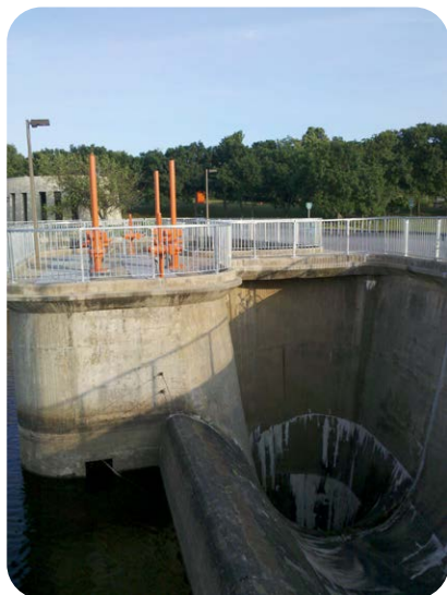
Digue principale du réservoir Choinière Crédit: SamuelFrelil/Wikipédia
